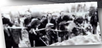
Der offizielle Spatenstich
